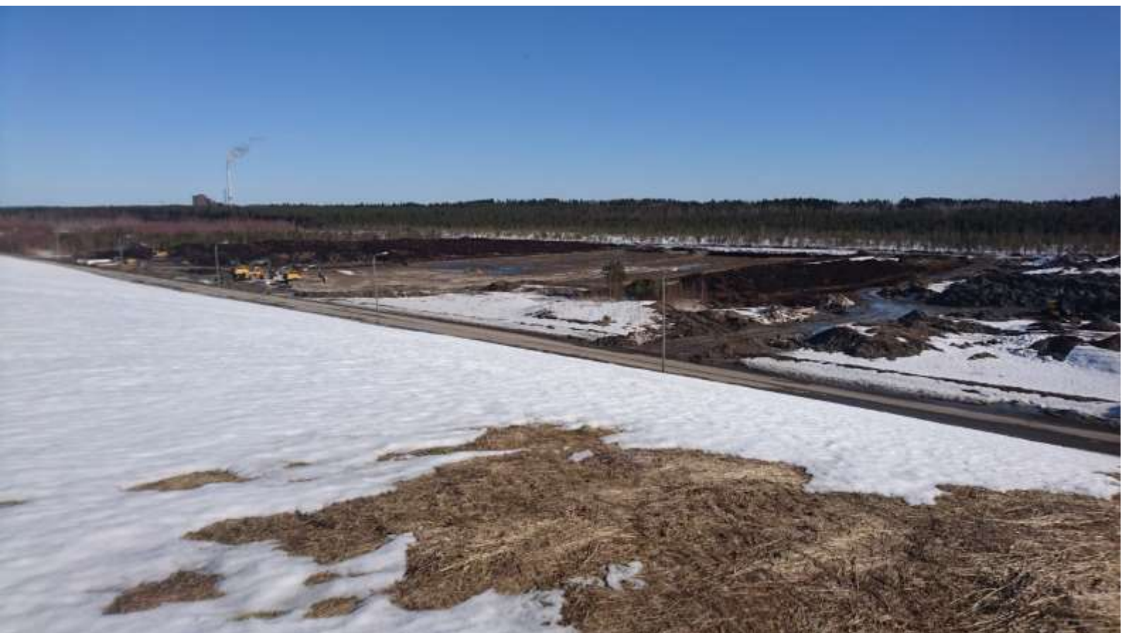
Kuva 2. Kontiosuon keskiosan mäntyräme myllerrettiin vuonna 2018 ja pohjustettiin sorakentäksi myöhempää rakentamista varten. 14.4.18.
